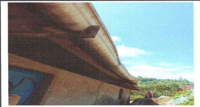
Foto 6: Cambio de canal y pescante.
